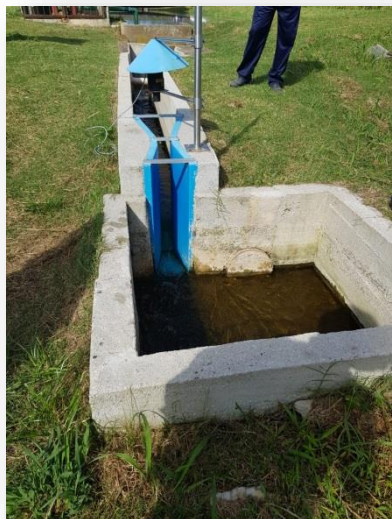
Local para coleta de efluente tratado
